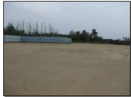
南羽咋の遊休地 工事完了状況（石川）
